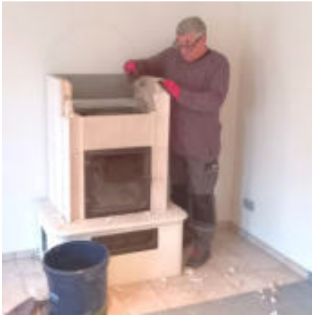
Frank Neuber bei den Renovierungsarbeiten; Fotos Ute Rentzsch
